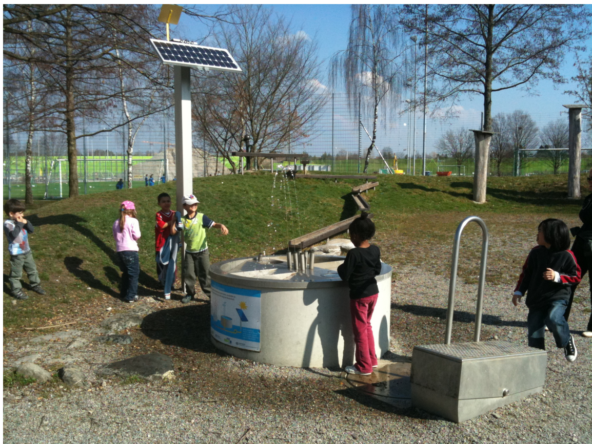
Solarbrunnen mit Wipppumpe Freizeitanlage Hirzenbach Zürich
